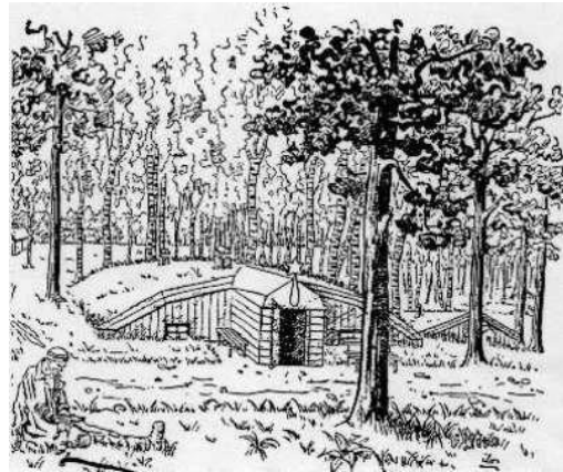
Baraquement appelé bunker à Tambov
