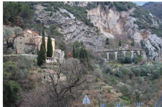
Col de Menton, viaduc de l'ancien tramway
